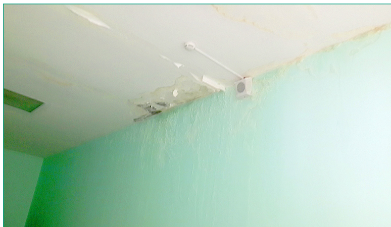
| Потолки в строящемся здании ГБОУ НАО «Средняя школа п. Красное»
