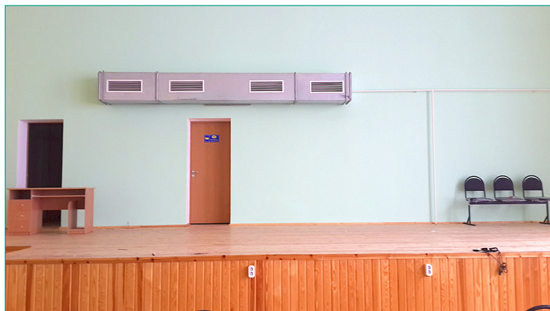
| Сцена в актовом зале в строящемся здании ГБОУ НАО «Средняя школа п. Красное»
